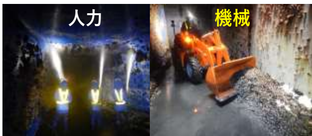
写真-2 取水路内除貝作業状況
