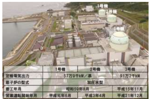
写真-1 泊発電所全体写真
